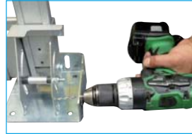
Fixer la balustrade sur le toit de cabine de chaque côté
